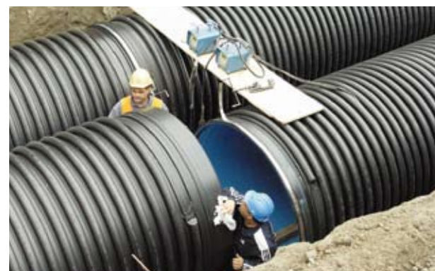
Зварювання труб великого діаметра у вузькій траншеї
