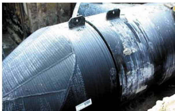
Перехід з DN/ID 2400мм на DN/ID 1200 мм
