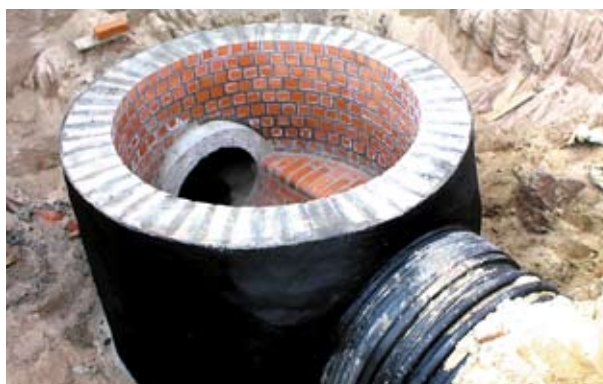
Труба Krahn з колодязем виготовленим з цегли
