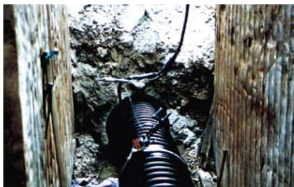
Релайнінг всередині бетонного трубопроводу
