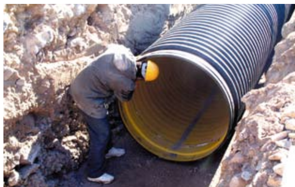
Монтаж труб Krah у вузькій траншеї
