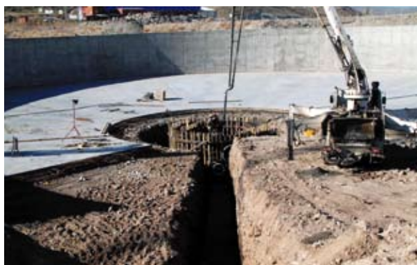
Монтаж ємностей зберігання води для басейну
