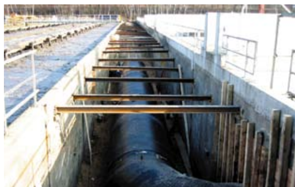
Відвід DN/ID 2000 мм
