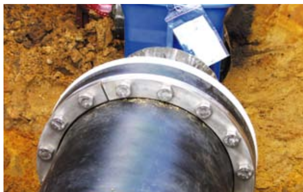
Фланцеве з'єднання
