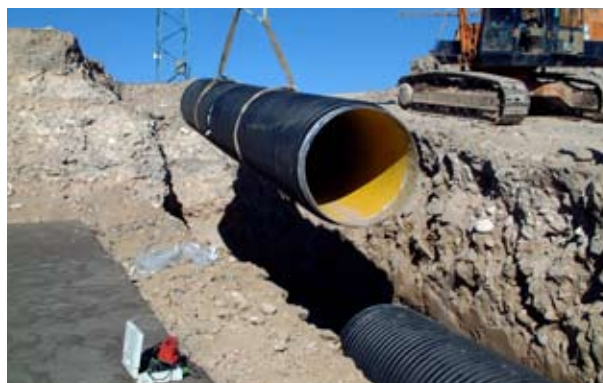
Монтаж попередньо зістикованих труб
