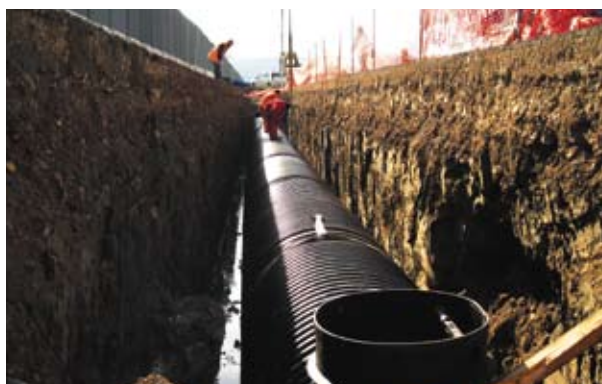
Процес прокладання труб
