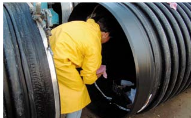
З'єднання труб з допомогою електроплавлення
