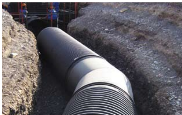
Монтаж трубопроводу DN/ID 2000 мм з фітингами
