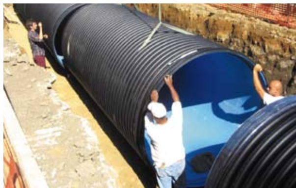
Монтаж трубопроводу DN/ID 2000 мм
