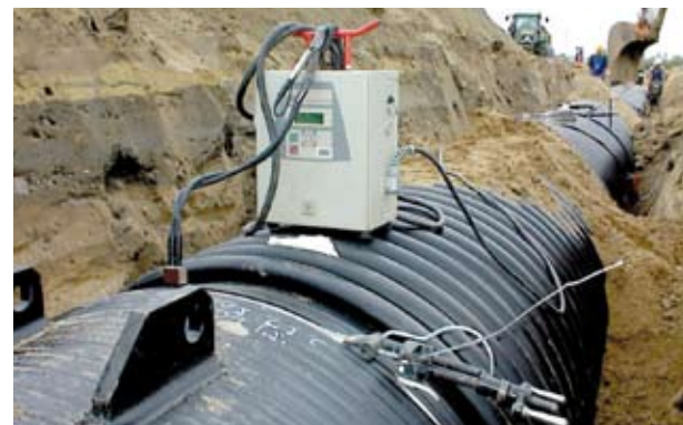
Процедура електроплавлення
