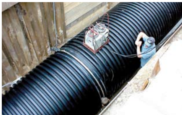
Виконання електрофузійного зварювання в траншеї
