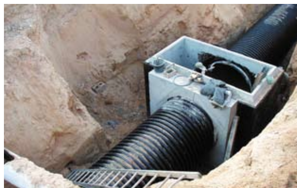
Монтаж трубопроводу з шахтами
