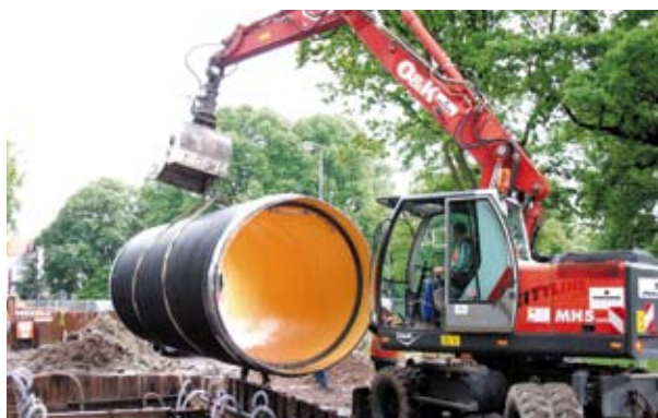
Установлення резервуару для дощової води
